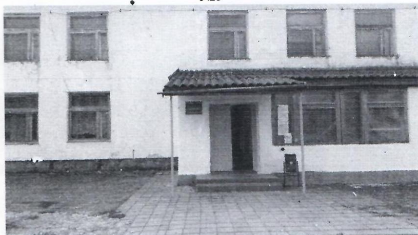
Входная площадка. Дверь (входная) №5
